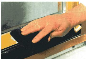
4. Rauhen Sie diese Grundierung - nach dem Trocknen - mit einem Schleifvlies leicht an.
