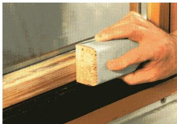
2. Schleifen Sie die Fensterriegel mit Schleifpapier (z.B. Kö.100) gründlich ab. Achten Sie dabei darauf, dass die Silikondichtung NICHT berührt werden darf (Silikonverseuchung des Untergrunds führt zu Haftungsstörungen des neuen Anstrichs)
