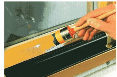
3. Imprägnieren Sie rohe Holzstellen mit Sikkens Cetol Aktiva oder mit Owatrol-Öl. Nach dem Trocknen streichen sie – nur die rohen, vergrauten Holzflächen – einmal **dünn** mit Sikkens Rubbol Ventura Satin -DECKEND - im Farbton der lasierten Fenster (ggf. ist zum vollständigen Abdecken der Verfärbungen ein zweiter dünner Anstrich nötig).
